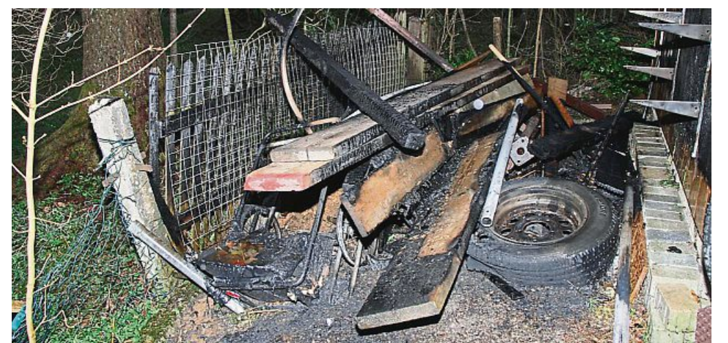
Verkohlt: die Rückseite des Geräteschuppens nach dem Brand.
