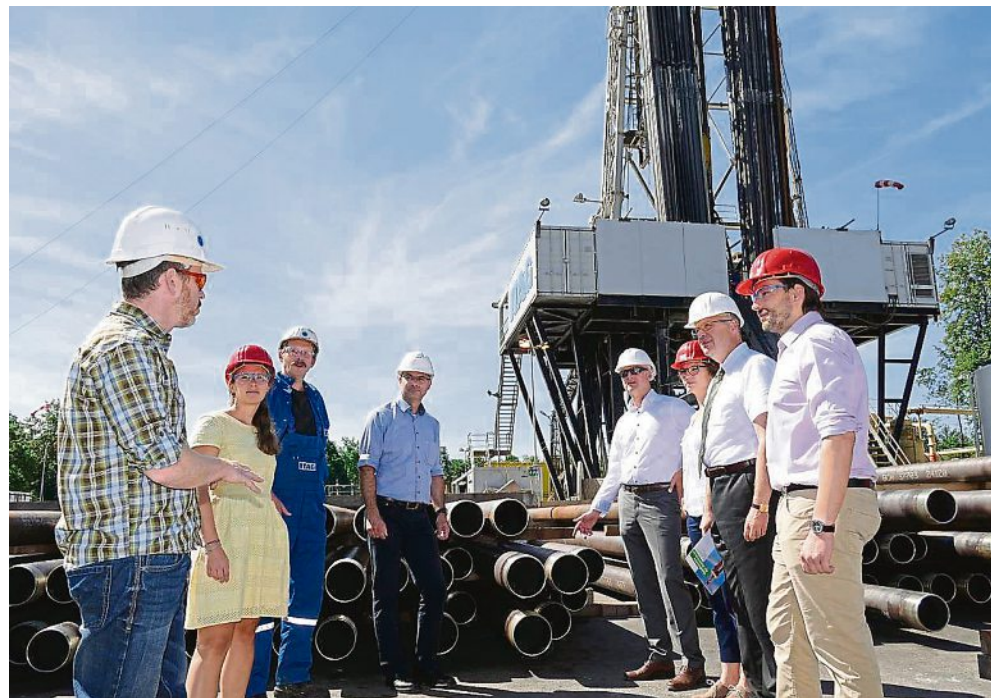
Besuch auf der Bohrstelle: Projektleiter Franz Böhm (l.) erklärt die aktuelle Lage. Unser Bild zeigt (ab 2. v. l.) Eva-Maria Schmitz (Standortförderung im Rathaus), Michael Fösser (Bohrfirma Itag), Albert Götz (Gemeindewerke), Bürgermeister Olaf von Löwis, Verena Sattler (Standortförderung), Alexander Radwan (Bundestags-Abgeordneter) und den Holzkirchner Unternehmer Martin Neumeier. FOTO: ANDREAS LEDER
