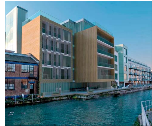
Die Fichtenbohlen aus dem Oberland werden in dieses Büro- und Wohngebäude mit Themse-Kanalzugang (dritter Baukörper von links) eingebaut. Fotos: WBV Holzkirchen
