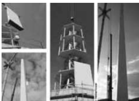
Der Aufbau des „Timbertower“
