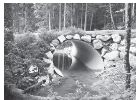
Moderner Wellstahldurchlass nach dem Einbau
