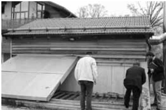
Im Neubaugebiet am Grünwalder Weg befindet sich das zweite Heizwerk. Mit einer Kesselleistung von 300 kW versorgt es 43 Einfamilienhäuser und Doppelhaushälften. Jedes Jahr werden rund 1.700 Srm Hackschnitzel benötigt. Die Belieferung und Betreuung wurde bereits vergeben.
