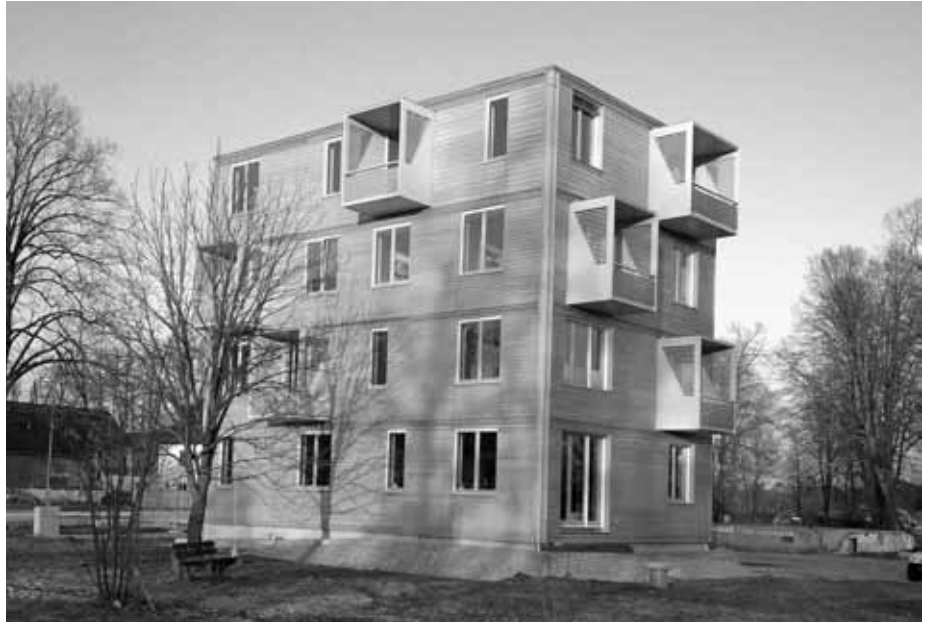
Viergeschossiger Holzbau in der Nullenergiestadt bei Mietraching (Bad Aibling) – Daneben wird gerade ein achttgeschossiges Holzgebäude mit Binder-Systembau-Elementen errichtet
