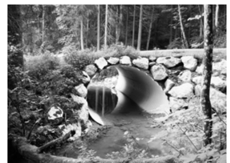
Moderner Wellstahldurchlass nach dem Einbau
