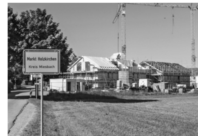
Kommunaler Wohnungsbau in Holzkirchen: Derzeit entstehen 16 Wohneinheiten in moderner Holzbauweise.
