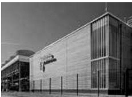
Die Geothermie Holzkirchen liefert seit Sommer 2019 Strom und Wärme
