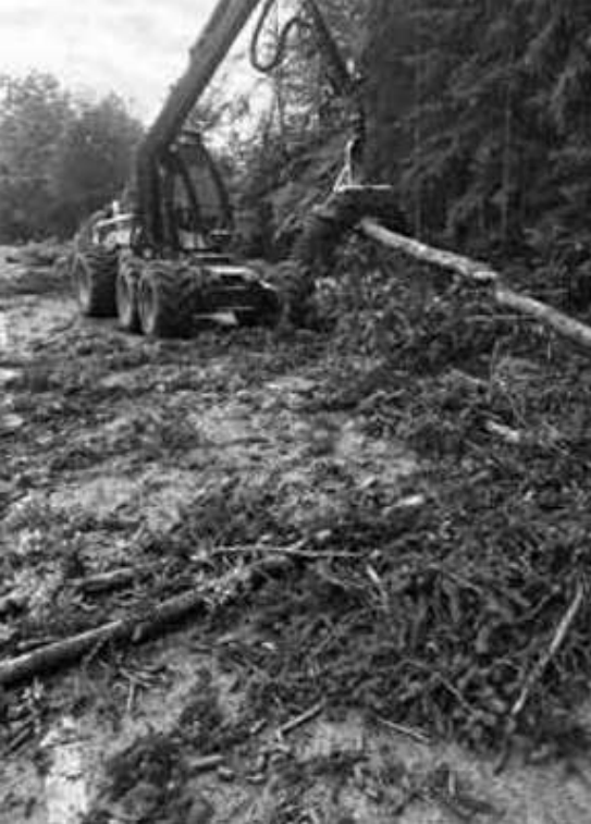
Arbeiten zur Verkehrssicherung an der MB 4 zwischen Fellach und Kreuzstraße, Valley
