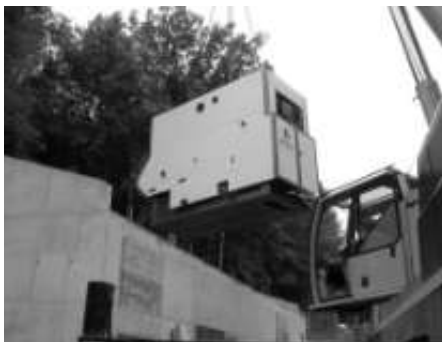
Der Biomassekessel wird in das Heizwerk eingehoben
