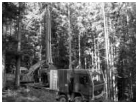
WBV-Seilkrahneinsatz mit Bagger-Prozessor an der Sigrizalm
