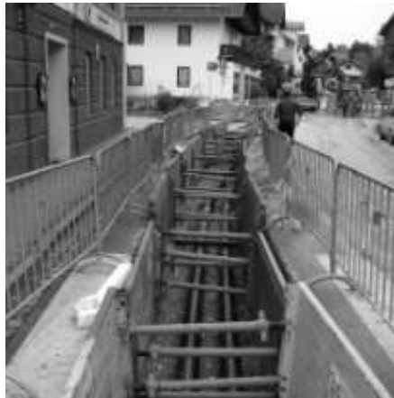
Trassenabschnitte mit Fernwärmeleitung
