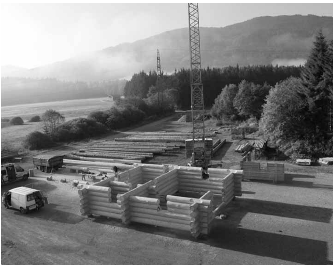
Ein Rundholzblockbau im Aufbau auf dem Betriebsgelände.
