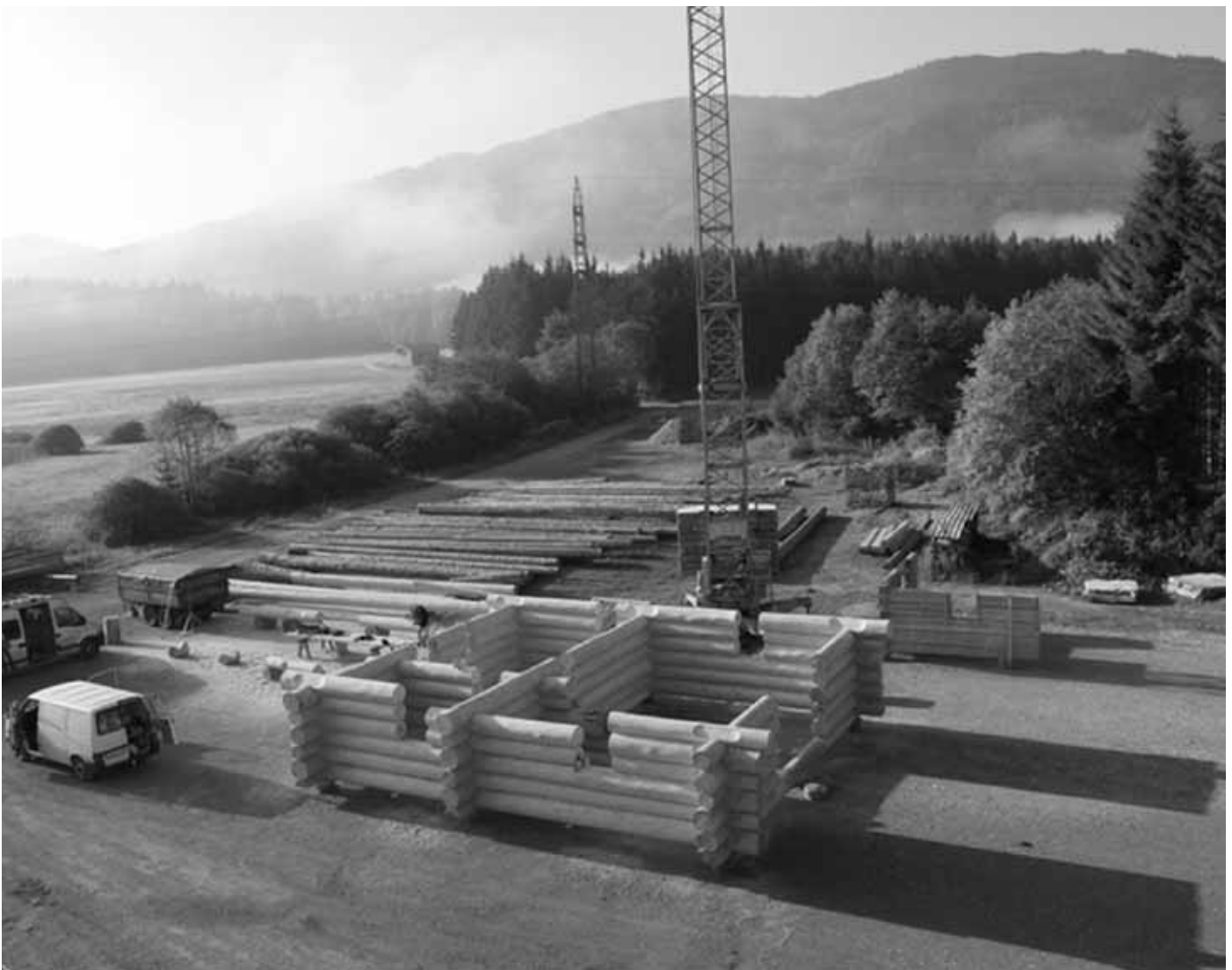
Ein Rundholzblockbau im Aufbau auf dem Betriebsgelände.
