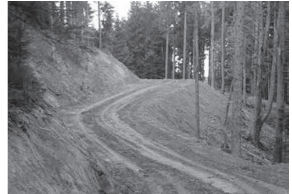
Wegebau am Leiterberg, hier nach Fertigstellung des Rohplanums
