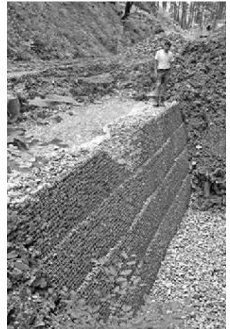
Alternative zur Krainerwand: Bewehrte Erde
