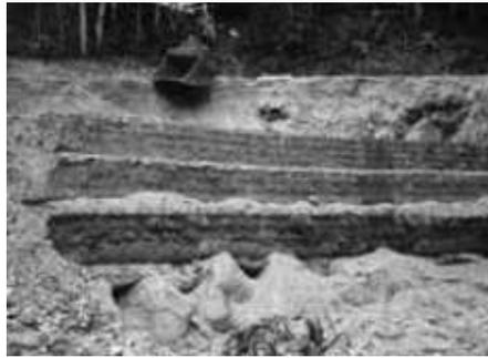
*Lageweiser Einbau des Systems „Kunststoff bewehrte Erde“*
