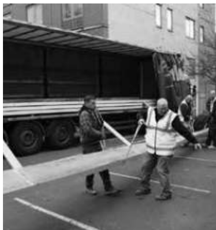
11. Dezember: Entladen an der Baustelle in London
